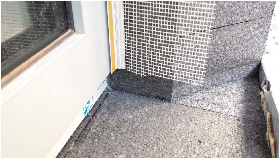
Abbildung 30: Detail der Abschrägung der Dämmung im Bereich der Fensterleibung [Quelle: Schöberl & Pöll GmbH]
