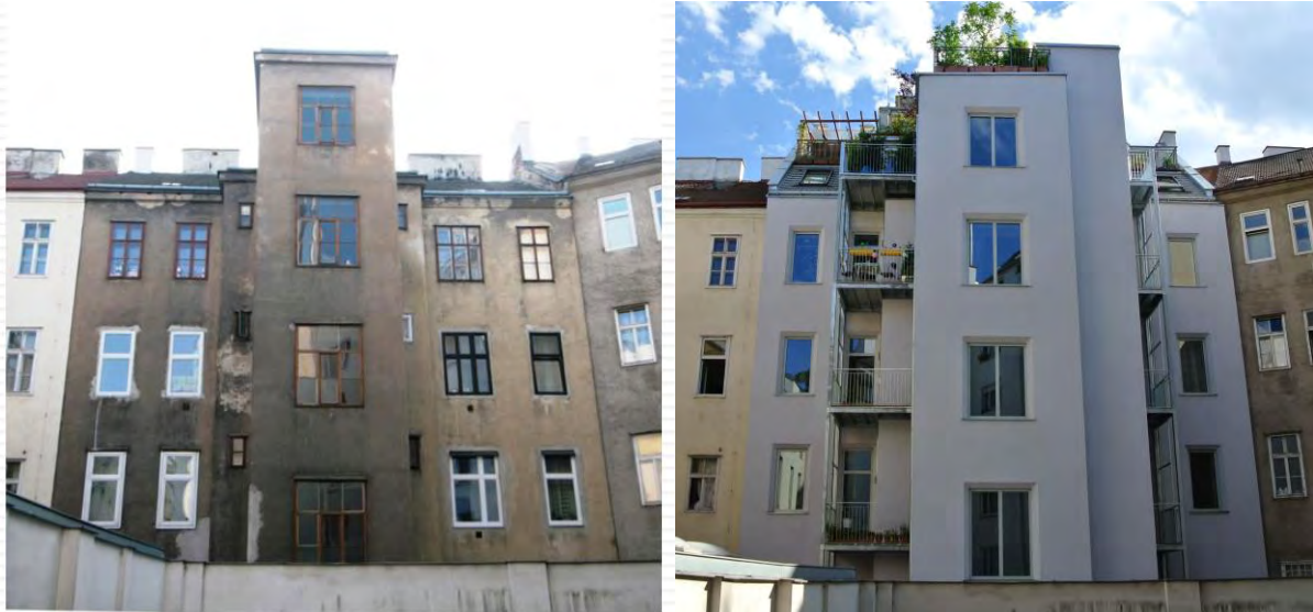
Abbildung 50: Hoffassade vor und nach Sanierung [Quelle: Andreas Kronberger]
