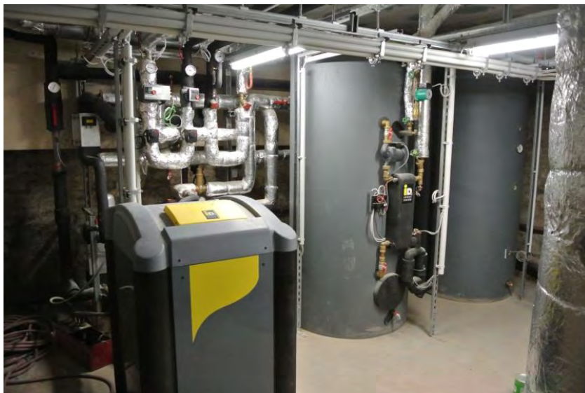
Abbildung 43: Grundwasser-Wärmepumpe und Wärmespeicher für Heizkreis und Warmwasserversorgung [Quelle: Andreas Kronberger]
