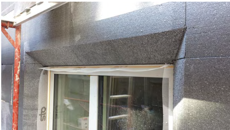
Abbildung 29: Abschrägung der Dämmung im Bereich der Fensterlaibung [Quelle: Schöberl & Pöll GmbH]
