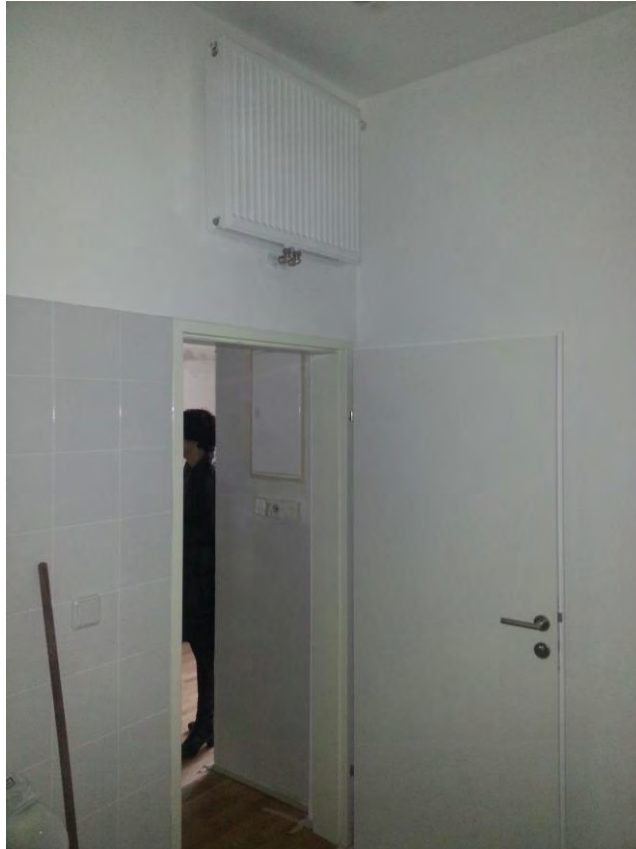
Abbildung 45: Anordnung eines Heizradiators über der Tür beim Projekt Eberlgasse [Quelle: Schöberl & Pöll GmbH]
