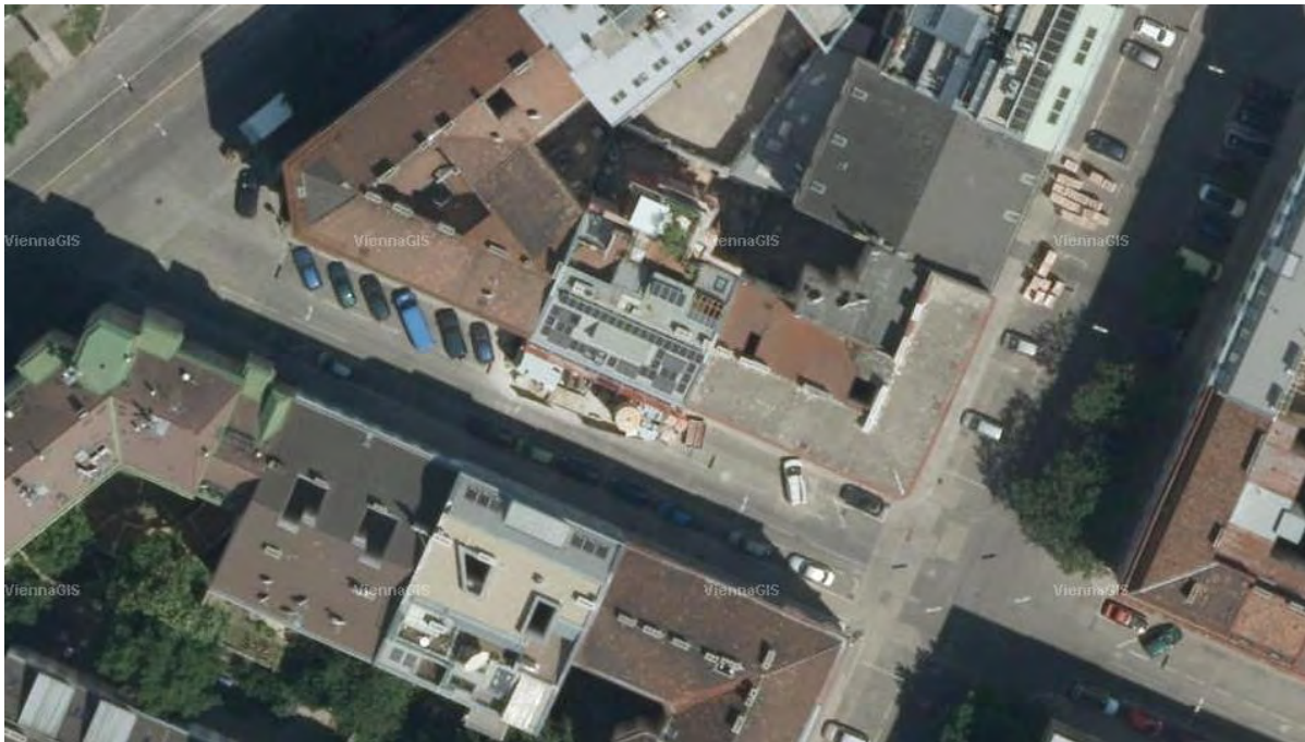
Abbildung 48: Luftbildaufnahme der abgeschlossenen Sanierung Eberlgasse [Quelle: Stadt Wien]
