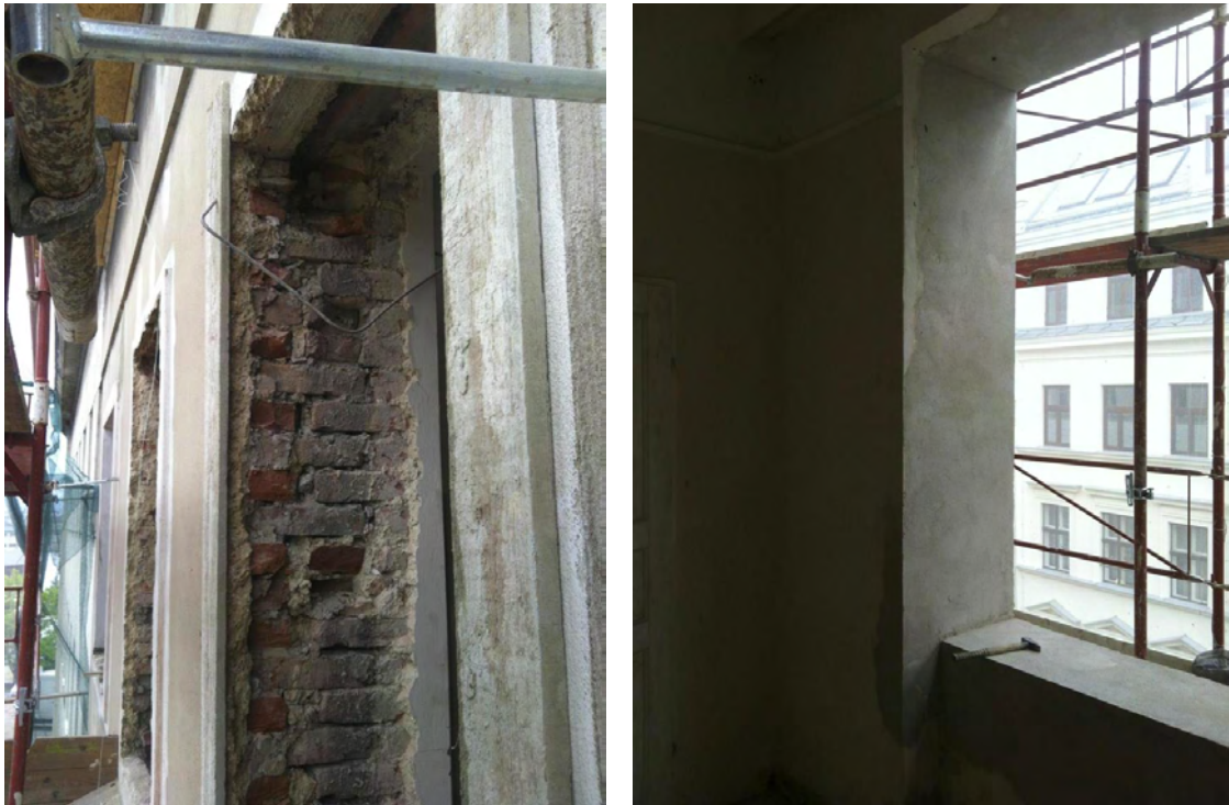
Abbildung 26: Fensterabbruch (links) und Glatzstrich (rechts) [Quelle: Andreas Kronberger]
