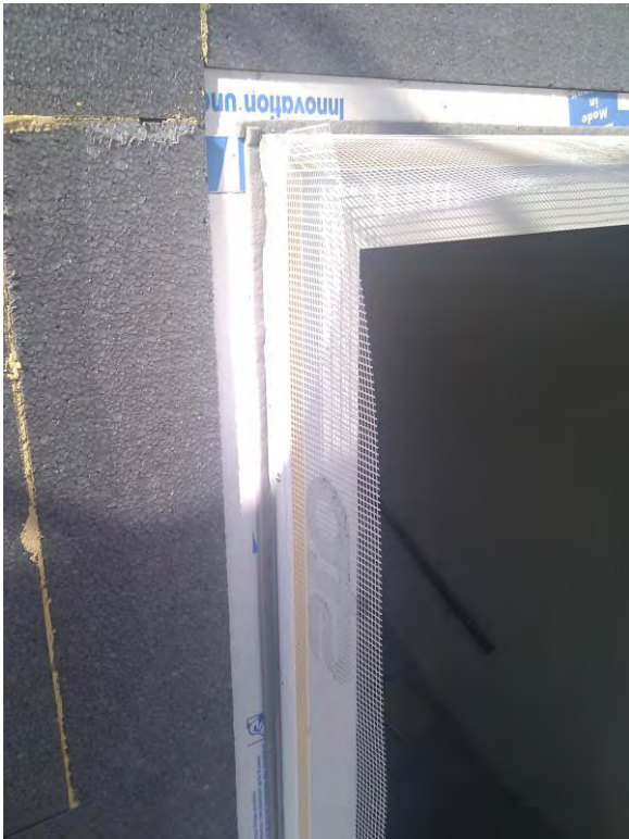
Abbildung 28: Positionierung der Fenster in der Dämmebene (links) und Überdämmung des Fensterstockes (rechts) [Quelle: Schöberl & Pöll GmbH]
