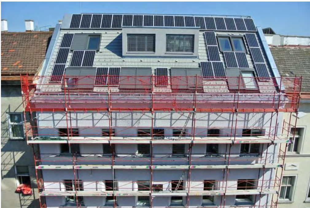
Abbildung 47: Fotovoltaikanlage am Dach [Quelle: Andreas Kronberger]
