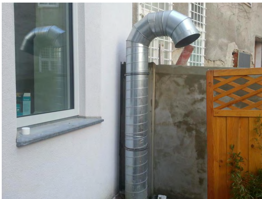
Abbildung 40: Außenluftansaugung im Hof [Quelle: Schöberl & Pöll GmbH]
