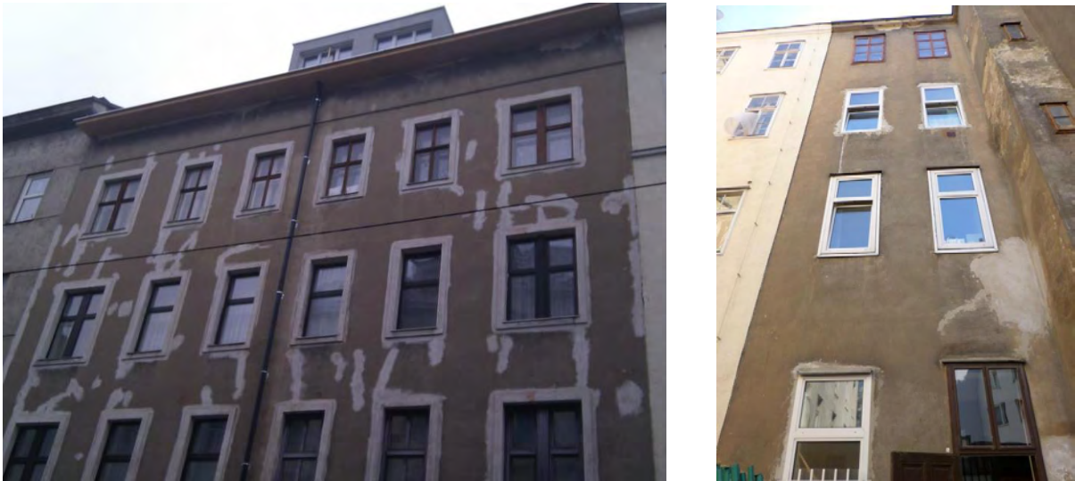
Abbildung 10: Unterschiedliche Fenstertypen, -konstruktionen und -baustoffe in Straßen- und Hoffassade [Quelle: Andreas Kronberger]
