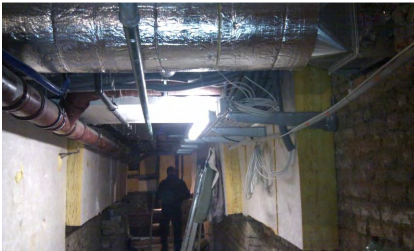
Abbildung 21: Kragendämmung aus Mineralwolle [Quelle: Ageres Baumanagement]
