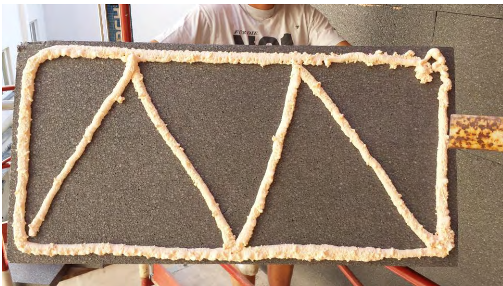
Abbildung 18: Randwulst-Streifen Verklebung der zweiten Dämmstofflage [Quelle: Schöberl & Pöll GmbH]
