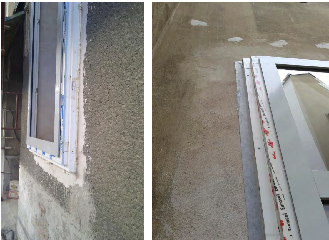
Abbildung 27: Fenstermontage vor das Mauerwerk (links) und winddichter Fensteranschluss (rechts) [Quelle: Schöberl & Pöll GmbH]
