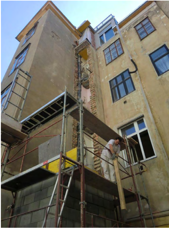
Abbildung 23: Neuer Aufzugschacht aus Betonschalsteinen [Quelle: Andreas Kronberger]
