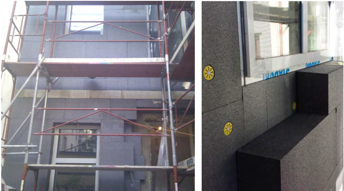
Abbildung 19: Zweilagige Fassadendämmung und geschossweiser Brandschutzriegel [Quelle: Schöberl & Pöll GmbH]
