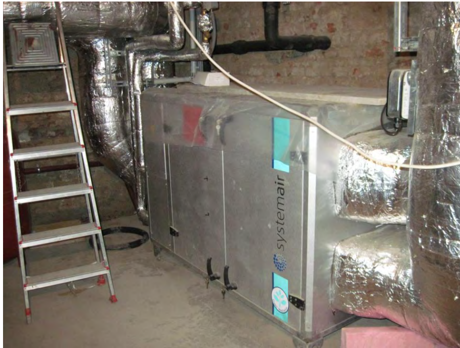
Abbildung 39: Zentrales Lüftungsgerät im Keller [Quelle: Andreas Kronberger]
