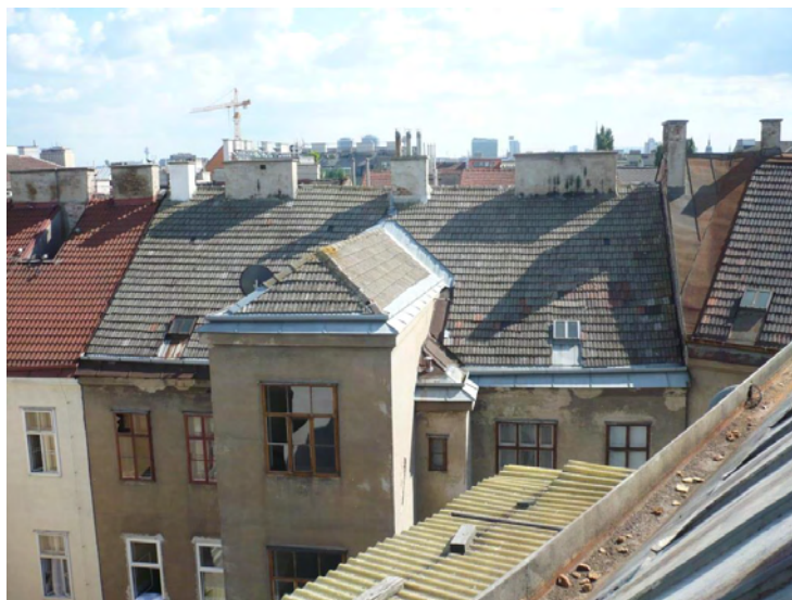
Abbildung 8: Hofseitige Dachansicht Eberlgasse [Quelle: Andreas Kronberger]
