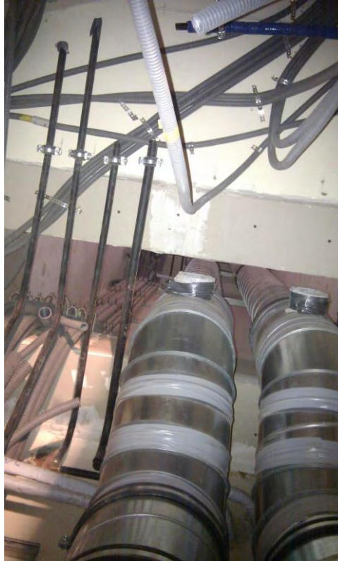
Abbildung 41: Steigschacht für vertikale Luftleitungsführung [Quelle: Ageres Baumanagement]
