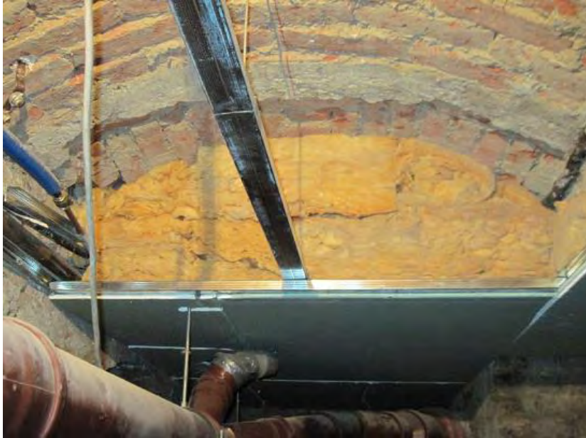
Abbildung 20: Dämmung der Kellerdeckenunterseite [Quelle: e7-Energie Markt Analyse]
