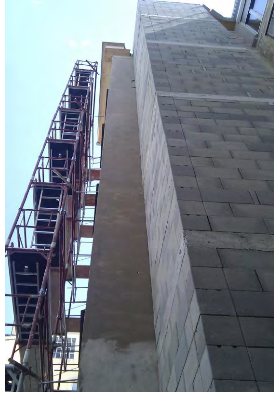
Abbildung 23: Neuer Aufzugschacht aus Betonschalsteinen [Quelle: Andreas Kronberger]
