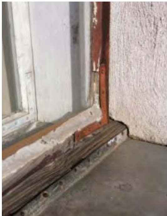
Abbildung 11: Zustand der noch vorhandenen Nachkriegsfenster vor der Sanierung [Quelle: Andreas Kronberger]
