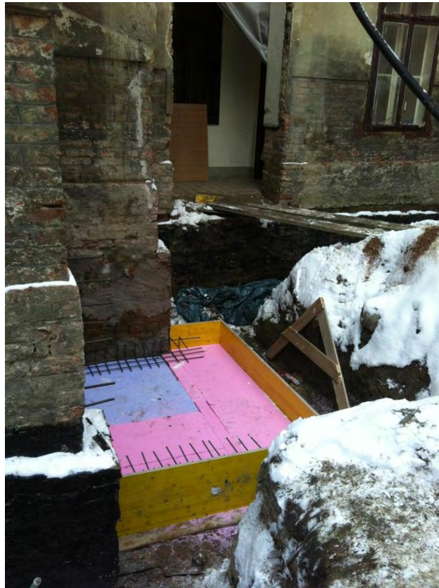
Abbildung 22: Dämmung der Bodenplatte des neuen Aufzugsschachtes [Quelle: Andreas Kronberger]
