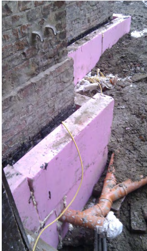
Abbildung 33: Perimeterdämmung entlang der Hoffassade vor Korrektur der optimalen Ausführung [Quelle: Ageres Baumanagement]
