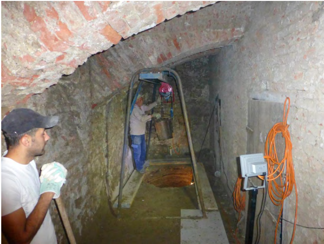
Abbildung 44: Grabungsarbeiten Brunnen [Quelle: Andreas Kronberger]
