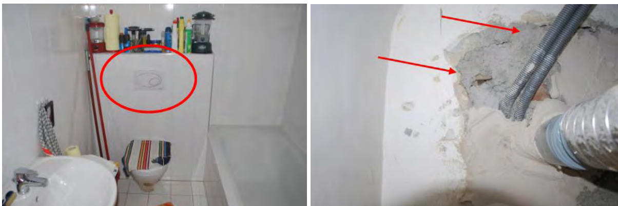
Abbildung 37: Lufttritt am Spülkastendrucker (links) und unzureichende Verputzung von Durchbrüchen (rechts) [Quelle: Ingenieurbüro Filos]
