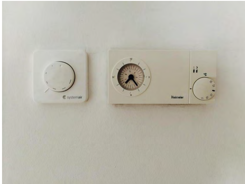
Abbildung 42: Regelung Lüftung und Heizung [Quelle: Schöberl & Pöll GmbH]
