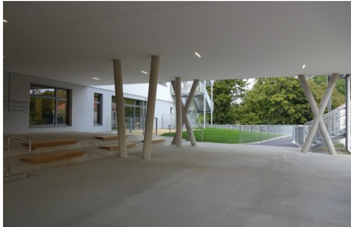
Ausragender Bauteil Vorplatz vor Schule + Kindergarten
