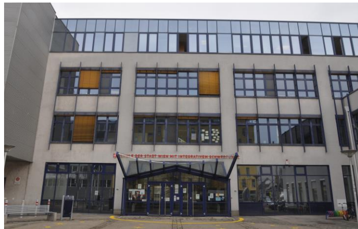
Südseite OG ohne Beschattung, Vorplatz versiegelt
