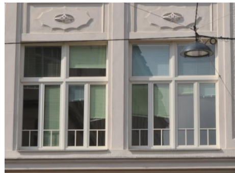
Südseitig, defekte Jalousien im Verbundfenster
