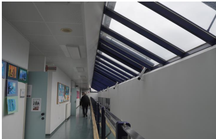
Süd-Ostseite - Gang Beschattung Außen textil / Windsensor Brandrauchentlüftung öffnet nicht zum Lüften
