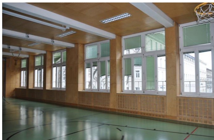
Südseite - Turnsaal Beschattung im Scheibenzwischenraum
