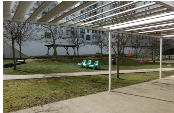
Vordach / Pergola - gebäudenah Lamellenkonstruktion vor Kindergarten
