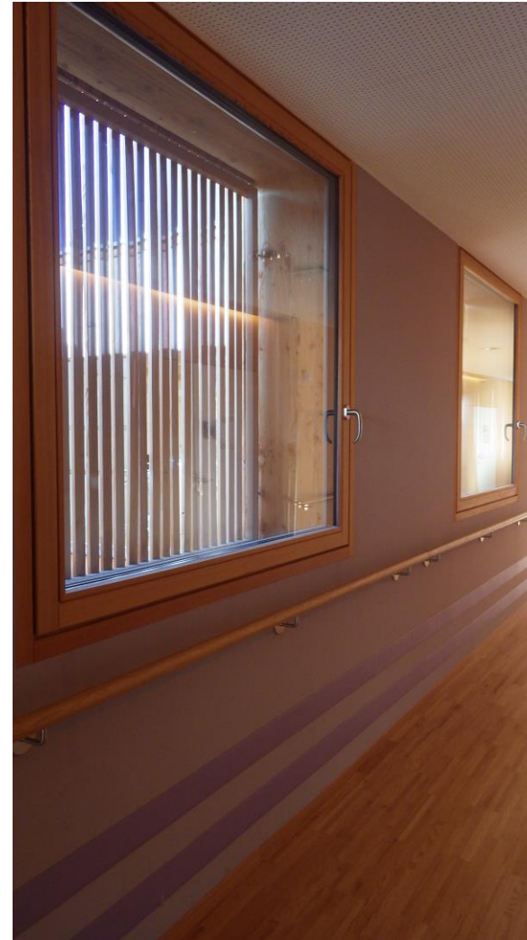
Fixer Sonnenschutz vor Fenstern im Gang
