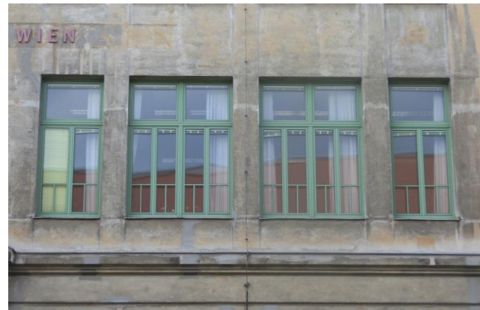
Ostseite Innenjalousien und Vorhänge
