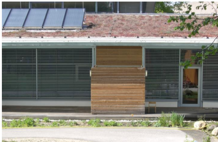
Vordach + Außenbeschattung + Extensives Gründach mit PV-Modulen
