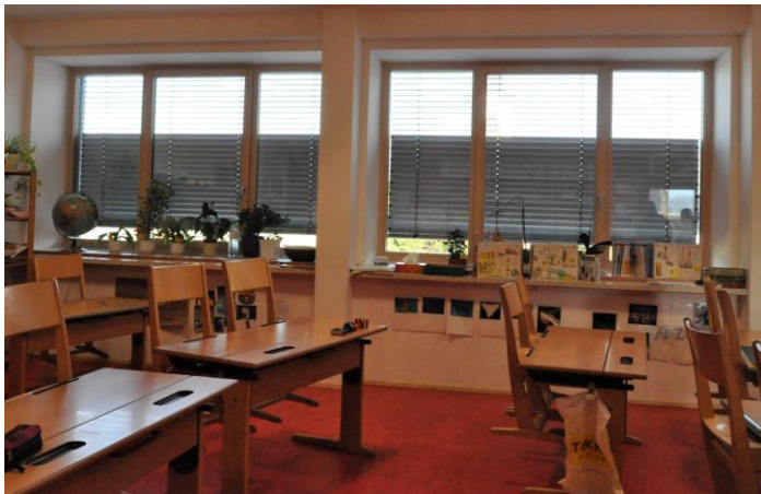
Außenverschattung Fenster Raffstores mit Lichtlenkung
