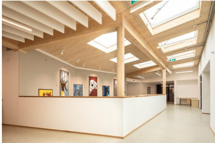
Oberlichten im Stiegenhauskern angesteuert für Nachtlüftung © aap.architekten
