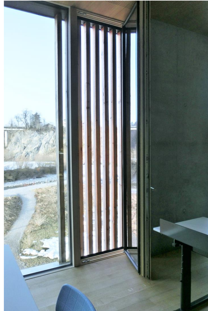
Fensterlüften Lamellen als Absturzsicherung, Einbruchschutz, Lüften in der Nacht möglich © aap.architekten
