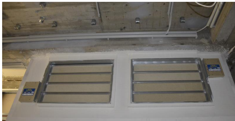
Abbildung: Lüftungs-Lamellen, z.B. zwischen Klassen und Gang, öffnen nachts automatisch (Querlüftung)
